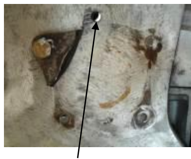
Alojamiento de bulón faltante
